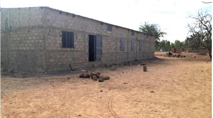
Das Gebäude ist 12 mal 25 Meter gross und durch ein einfaches Blechdach geschützt. Die Fenster sind mit Insektenschutz versehen.
