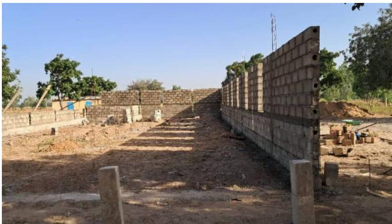
Auf dem Gelände selbst wurden die Ziegelsteine fabriziert, getrocknet und dann für den Bau verwendet.
