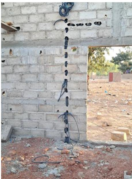
Vorausplanend wurden schon einmal die Röhren für mögliche elektrische Leitungen eingeführt.
