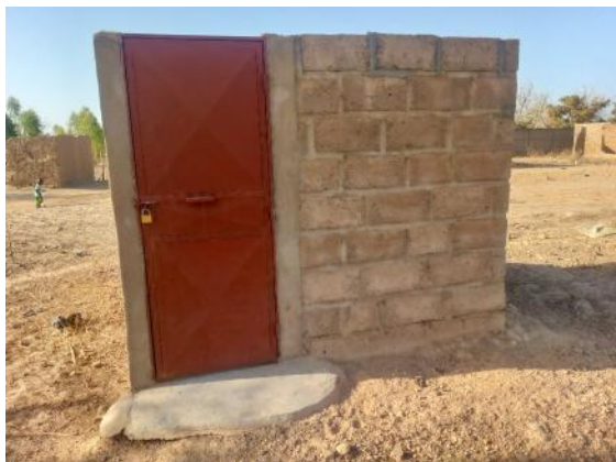
Toilettenhäuschen auf dem Gelände
